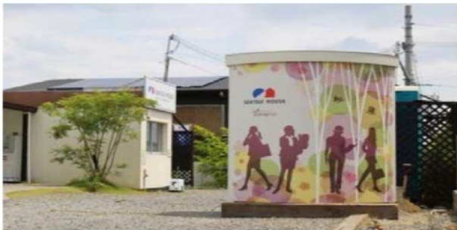
住宅分譲地に設置した「おりひめトイレ」
